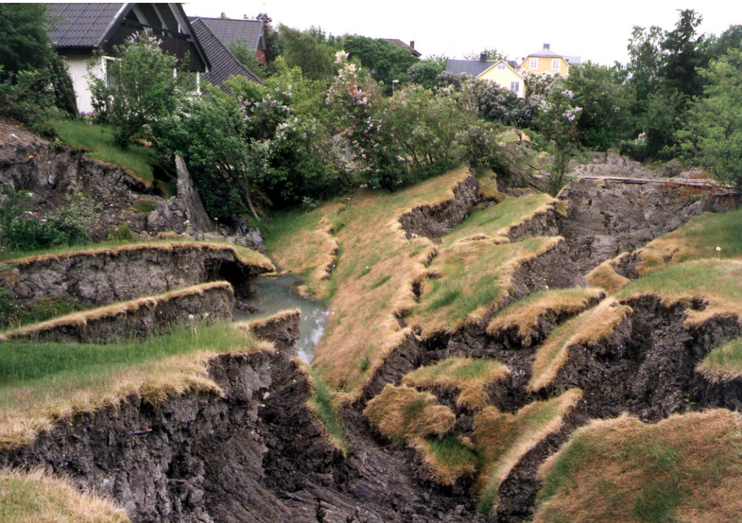
The Vagnhärad landslide 1997
